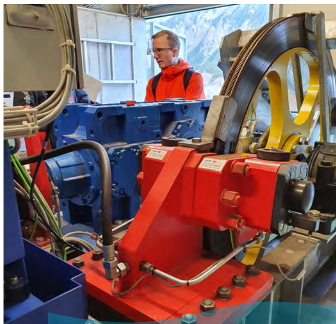
Inbetriebnahme eines U1000 im Schrägaufzug
